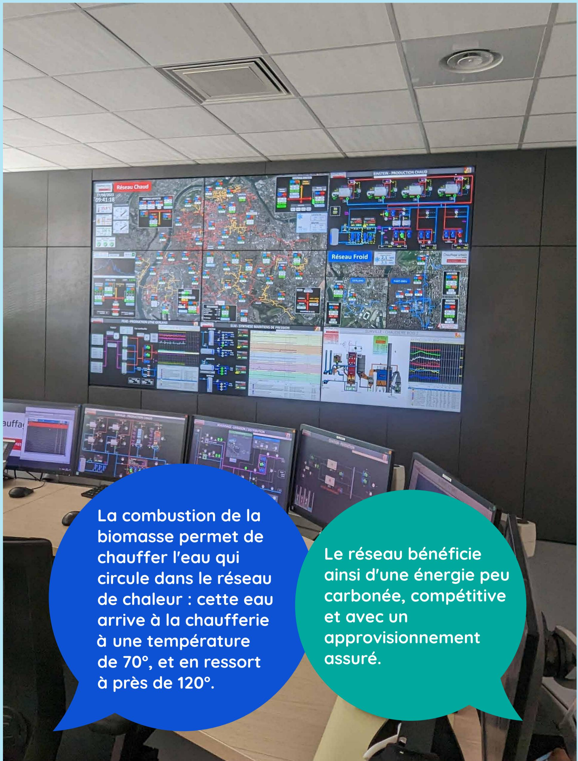
La combustion de la biomasse permet de chauffer l'eau qui circule dans le réseau de chaleur : cette eau arrive à la chaufferie à une température de 70°, et en ressort à près de 120°.
